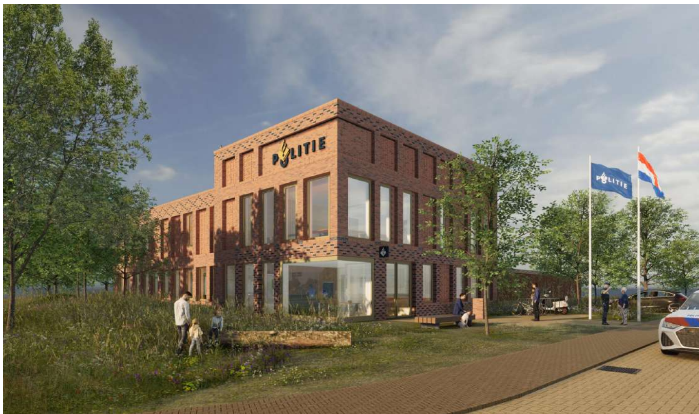
De bijzondere buitengevel bestaat uit relatief bewerkelijk metselwerk en steenstrips.
